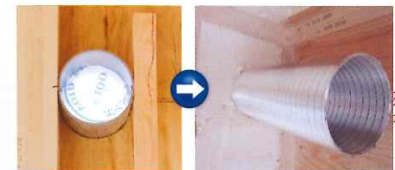
●隙間のできやすい配管部分も 充填し高气密を実現します
